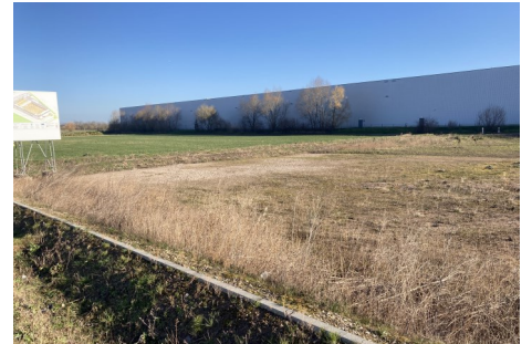
Direkt neben die neue Turnhalle im Bürgel wird die Vereinslagerhalle gebaut! Ein Quantensprung für die Bodenheimer Vereine! Bild: privat
