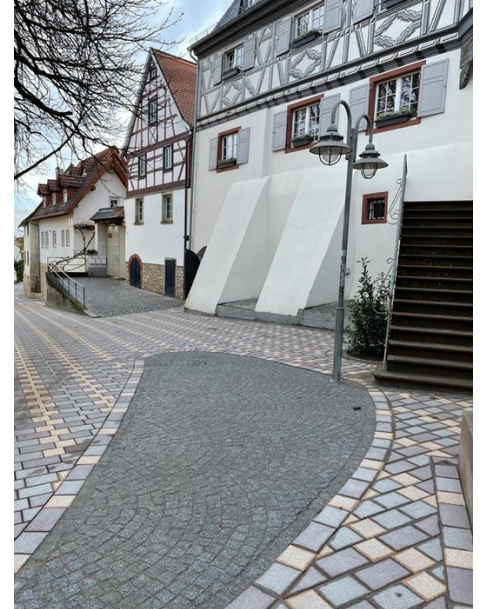
Ortskernsanierung: Straßenumbau Mainzer Straße, Bild: privat
