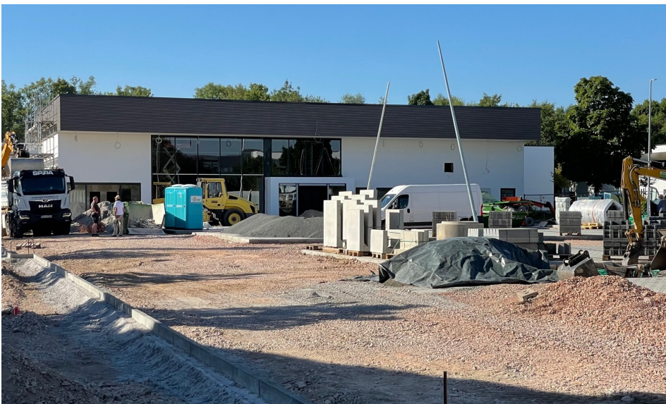
Die neue Tegut Filiale in Bodenheim kurz vor Fertigstellung . Bild: privat
