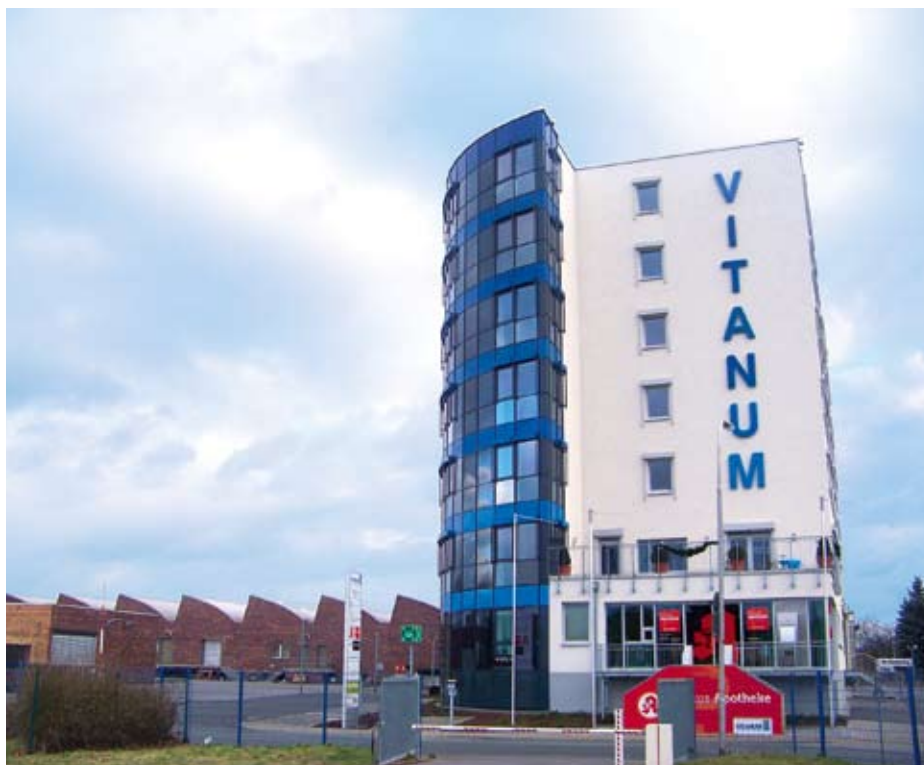
Sinnbild des erneuerten Bodenheimer Wirtschaftsstandortes: Das Ärztehaus „Vitanum“! Links daneben der Standort des künftigen Bodenheimer REWE-Einkaufsmarktes. Hier haben die Abrissarbeiten aktuell begonnen.
